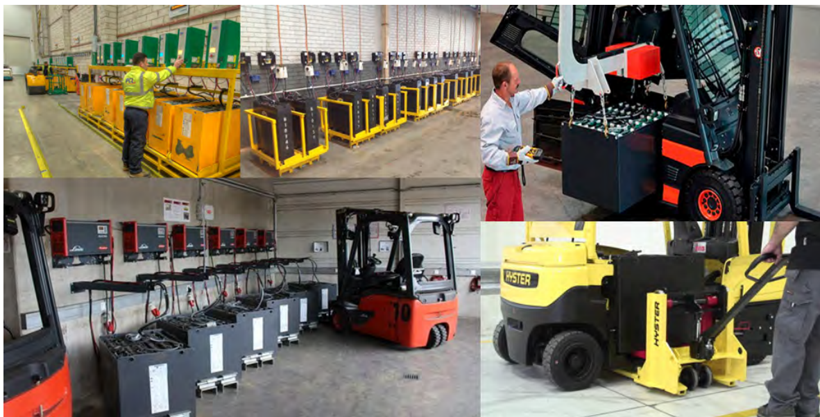
Figura 1 - Aree per la ricarica e operazioni di sostituzione batterie
